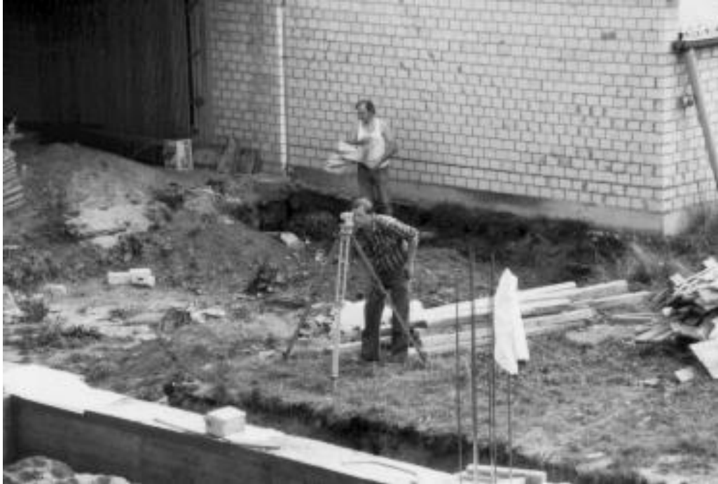
Hier ist exaktes Arbeiten gefragt
